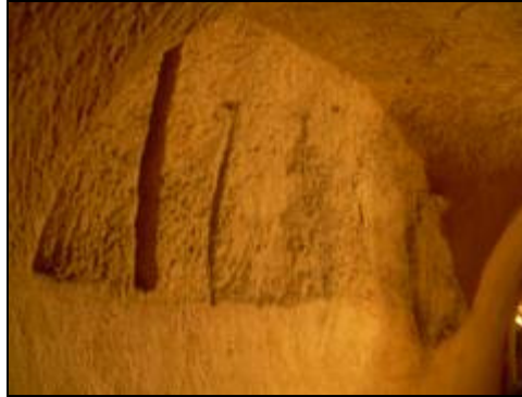
A kőfejtő csákányok nyoma az Óhegy-park alatti pincerendszerben
